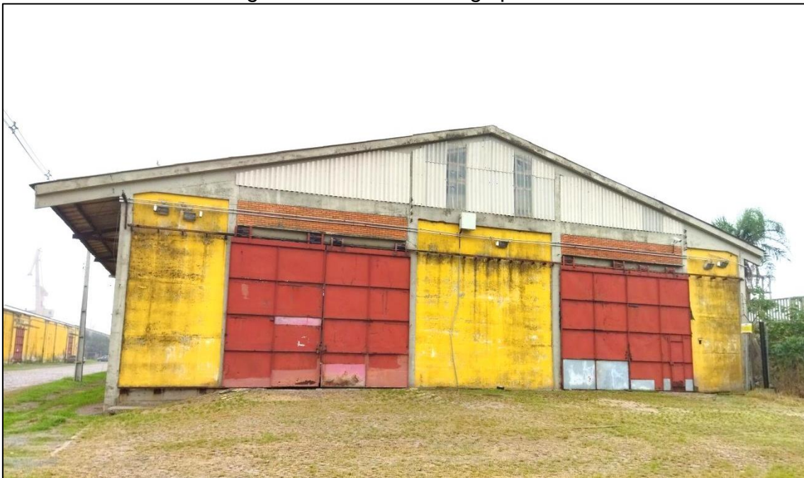
Figura 3 – Fachada Sul galpão E1.
