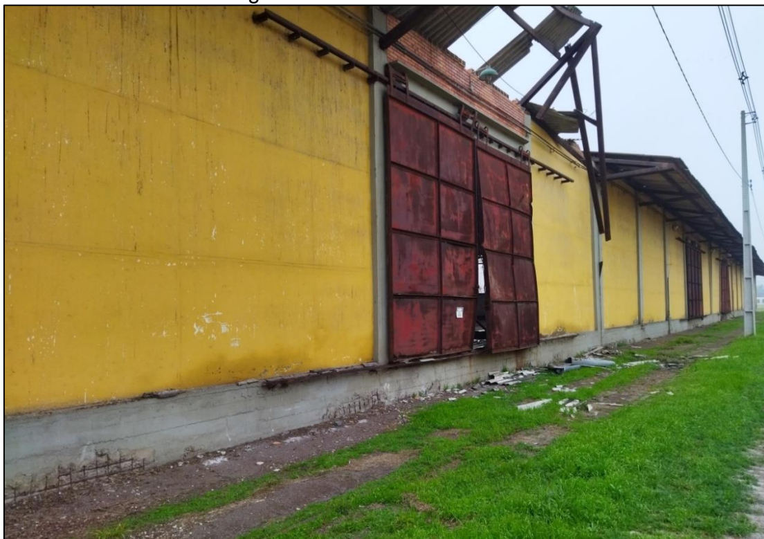
Figura 4 – Fachada lateral Oeste.
