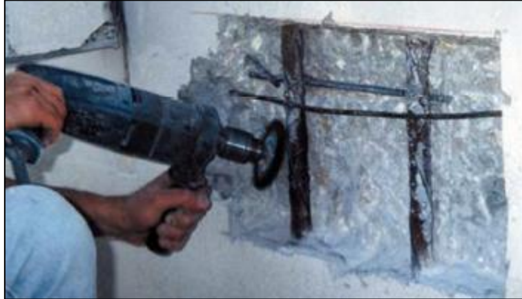
Figura 26 – Remoção da corrosão com lixadeira elétrica
