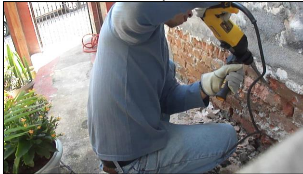
Figura 24 – Exemplo de remoção com ferramenta elétrica.
