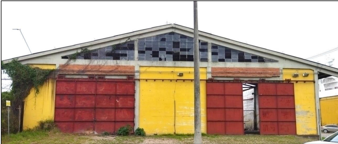
Figura 2 – Fachada Norte do galpão E1
