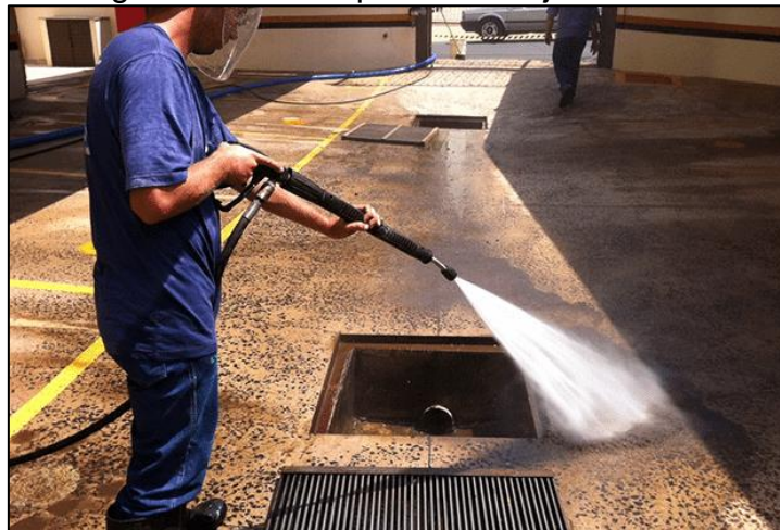
Figura 21 – Exemplo de Hidrojateamento
