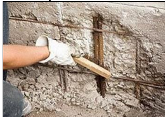
Figura 25 – Remoção da corrosão com escova de aço
