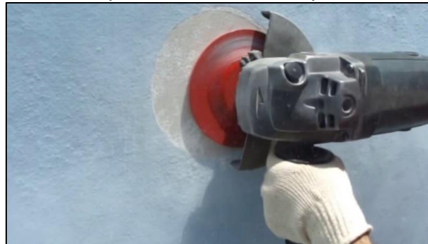
Figura 23 – Exemplo de desbaste em parede de concreto.
